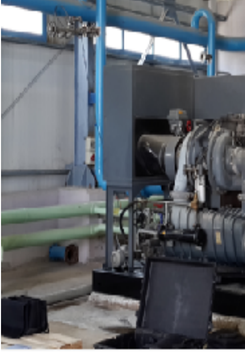
Türbin flowmetre ile kompresör çıkışı debi ölçümü (kurutucu öncesi)
