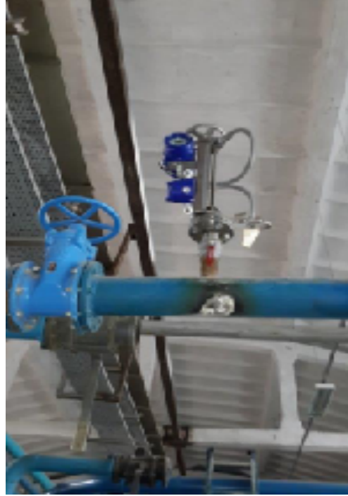
Türbin flowmetre ile kompresör çıkışı basınçlı hava debi ölçümü
